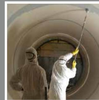
ECLATIN gehört zu den führenden Herstellern von hoch resistenten Beschichtungssystemen für den Stahlwasserbau. Geprüfte und zertifizierte Systeme garantieren Sicherheit und Langlebigkeit. Ob in einer Schiffswerft, auf einer Brücke bei rauhem Klima oder in nasser, kühler Umgebung: feuchtigkeitshärtende PU Beschichtungen bieten auch unter widrigen klimatischen Bedingungen gute Applikationsmöglichkeiten – ohne Beeinträchtigung der Trocknungszeiten und der Qualität.
