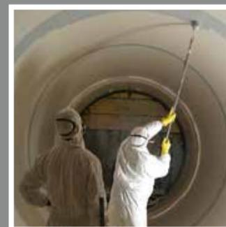
ECLATIN est l'un des principaux fabricants de systèmes de revêtement hautement résistants pour la construction hydraulique en acier. Des systèmes contrôlés et certifiés garantissent la sécurité et la longévité. Dans un chantier naval, sur un pont soumis à un rude climat ou dans un environnement humide et froid: les revêtements PU durcissant à l'humidité s'appliquent parfaitement même avec une météo défavorable – sans impact sur les temps de séchage ni sur la qualité.
